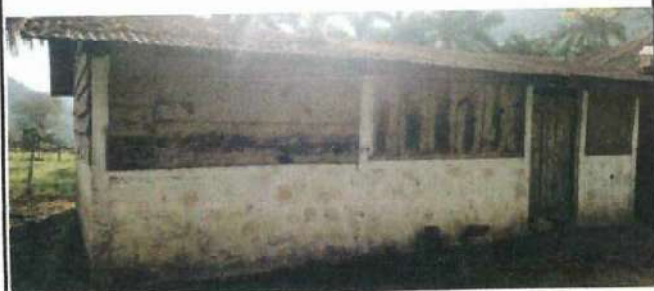
Foto 1: Sustrución de estructura de techo.
