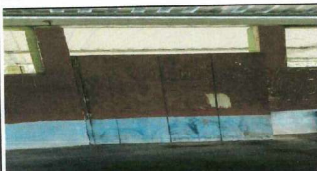
Foto 3: Sustrución de puerta de madera a metal del modulo 01.
