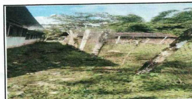
Foto 6: Mantenimiento de circulado perimetral.
