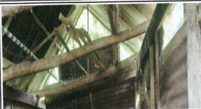
Foto 2: Sustrución de cambio de lamina.
